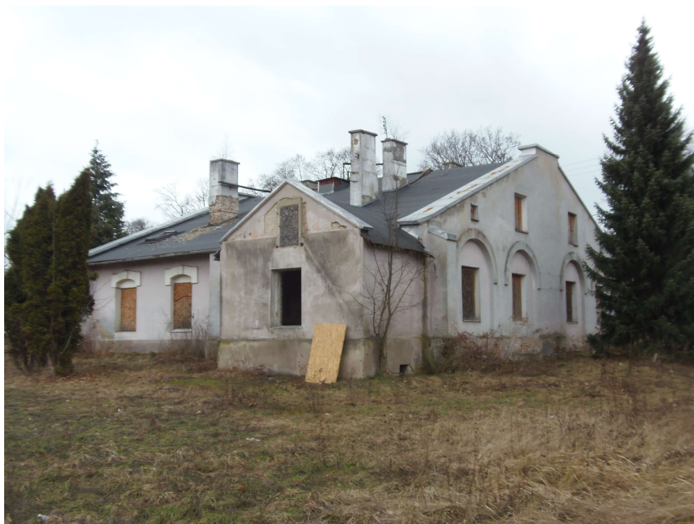
Rys. 4. Budynek dawnej parowozowni kolei Wilanowskiej, wpisany do rejestru zabytków.
